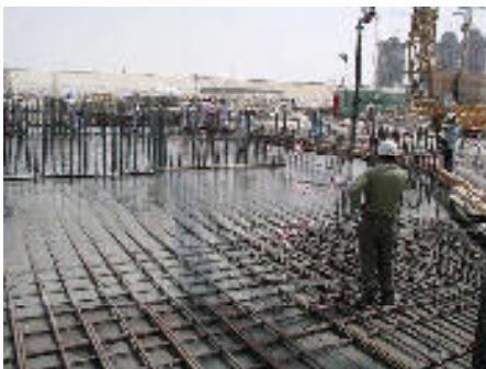
Figure 9 - Reinforced Concrete Raft Pour
